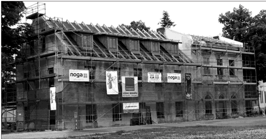
V přízemí Myslivny budou po rekonstrukci nebytové prostory, v prvním patře kanceláře a v podkroví byt a jedna kancelář. Foto: Pavel Čempěl
