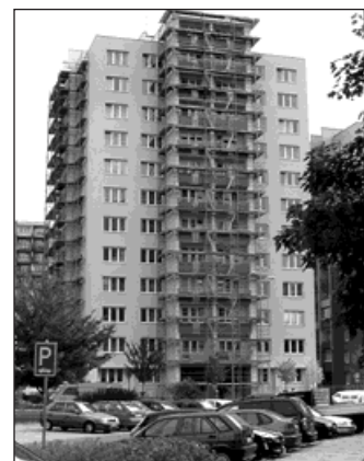
Loni byl rekonstruován dům v ulici Svatopluka Čecha 1093.
