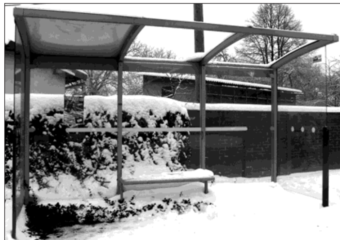
V Záblatí u pošty poškodila »vichřice« autobusové čekárny v obou směrech. Foto: Ivo Lenoch
