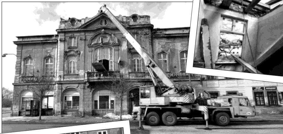
Jeřáb dopravuje nahoru materiál - hranoly a fošny. Na rozebírání krytiny postačí obyčejný krumpáč. Foto: Pavel Čempěl
