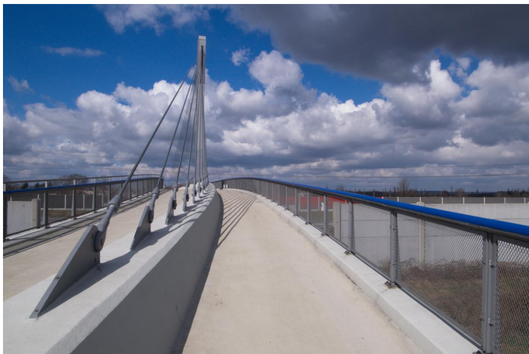
Obr. 1 Trasa P – Bohumínská lávka
