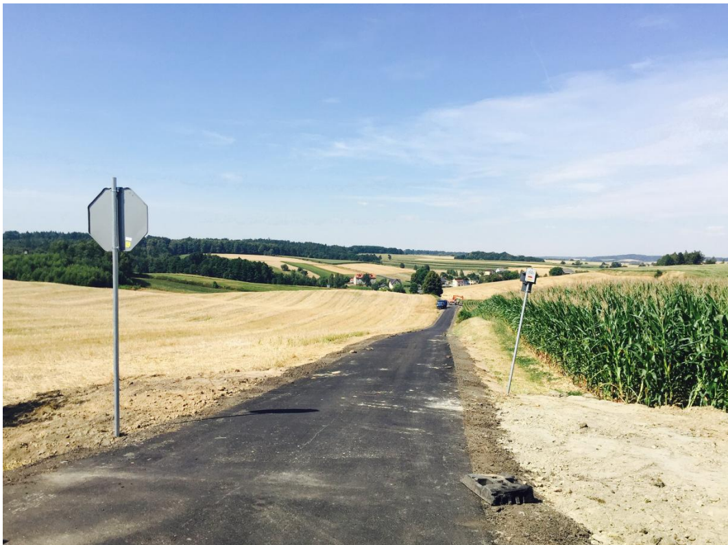
Obr. 7 Nově opravená stezka – sjezd do obce Owsiszcze
