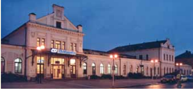
Novorenesanční budova nádraží v Novém Bohumíně patří k nejhezčím v České republice. Neo-Renaissance building of the railway station in Novy Bohumin - one of the most beautiful stations in the Czech Republic.
