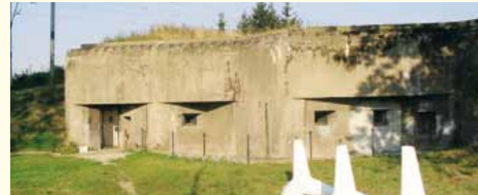
Pěchotní srub MO-S5 Na Trati je kulturní památkou. Obiekt fortyfikacyjny MO-S5 „Na torach“ to zabytek techniki.
