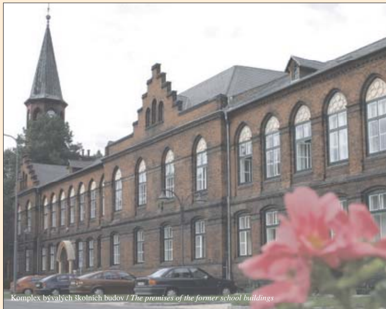
Komplex bývalých školních budov / The premises of the former school buildings
