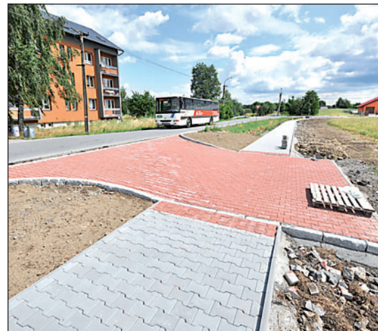
Nový 650 metrový chodník vede podél Rychvaldské a Sokolské ulice v Záblatí. Loni město investovalo do oprav chodníků v osmnácti lokalitách celkem sedm milionů korun. Obnovy se dočkalo i jedenáct úseků městských silnic.
