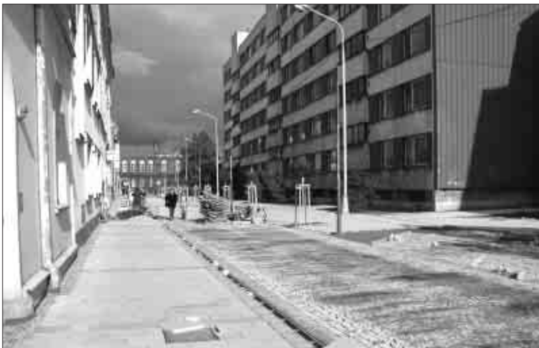
▲ Komenského ulice bude spolu s ulicí Masarykovou po tříměsíční rekonstrukci slavnostně otevřena 26. října.
