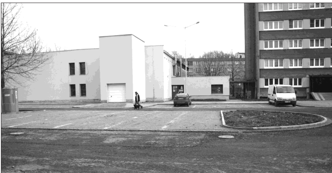
▲ Nové parkoviště na Nerudově ulici vzniká v rámci projektu regenerace.
