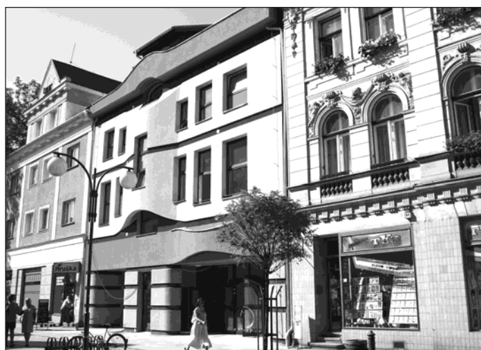
▲ V přízemí domu bude brzy otevřena kavárna s cukrárnou. Objeví se tu také předzahrádka s příjemným posezením. Foto: František Krejzek
