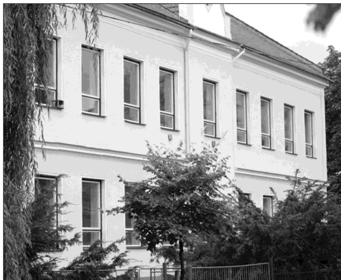
▲ Nová fasáda školní budovy na Masarykově ulici v centru města.
