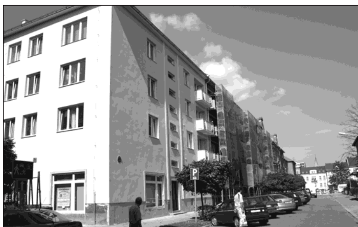
▲ Dlouhá fronta domů podél náměstí T. G. Masaryka prochází rekonstrukcí. Mění se zde okna a omítají fasády. Foto: František Krejzek
