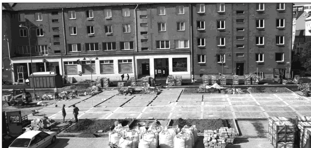
▲ Odpočinková zóna v centru města na náměstí T. G. Masaryka, která zde vzniká namísto parkoviště, je pokračováním přestavby centra města. Vzhled centra vylepší také nové fasády. Foto: František Krejzek
