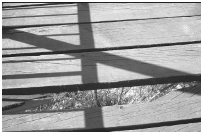
▲ Stav podlahy Antošovické lávky k 23. dubnu 2007. Tato zlomená deska již mezitím byla vyměněna. Foto: Ivo Lenocho
