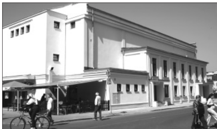
▲ Okolo kina už zmizela drátěná stavební ohrada. Bílá budova se stane po rekonstrukci důstojným stánkem kultury. Foto: František Krejzek
