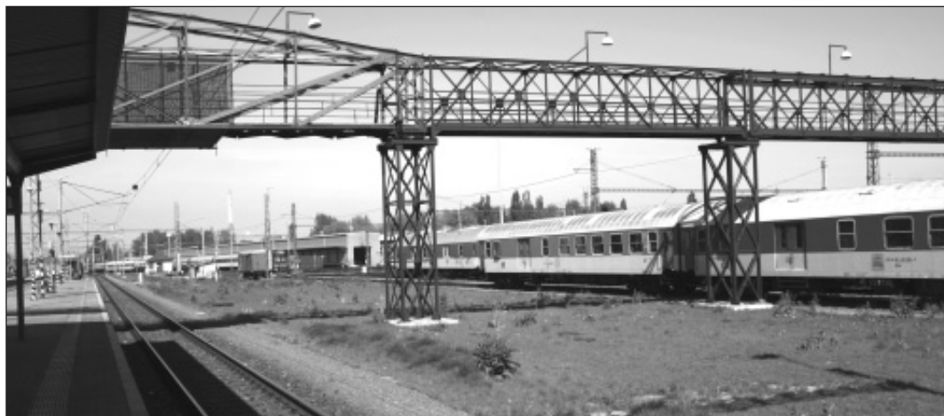
▲ Lávka přes kolejiště patří mezi technické památky města.
