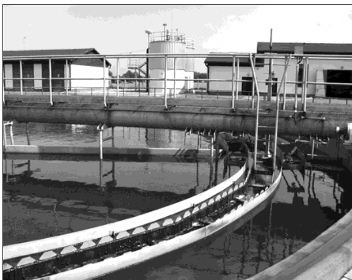
▲ Do budování čistírny odpadních vod a kanalizačních sítí investovalo město za deset let přes 245 milionů korun. Foto: F. Krejzek
