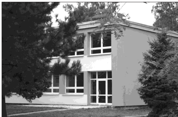
▲ Fit školka má novou fasádu budovy družiny a vyměněná okna. Zateplení pláště školy je před dokončením. Foto: František Krejzek
