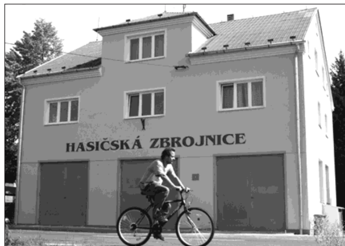
▲ Opravená hasičská zbrojnice v Záblatí..
