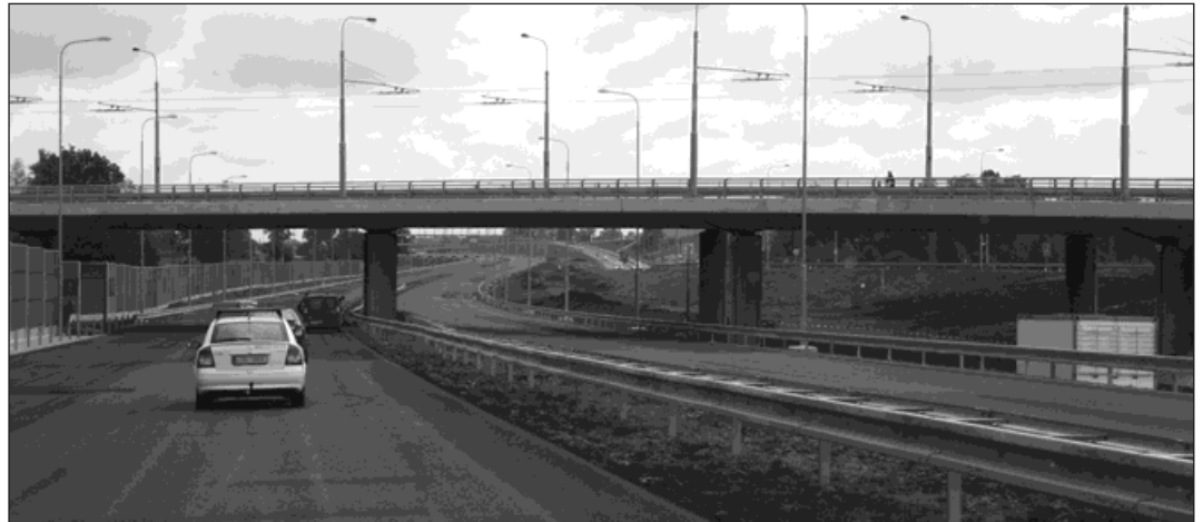
▲ Příjezd po dálnici od Ostravy v místě křižování s nadejzdem směr Hrušov - Koblov.
