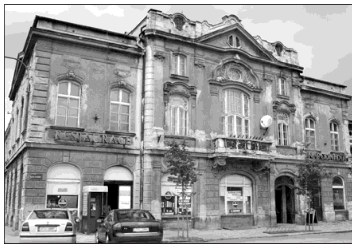
Dnešní stav památkového objektu již volá po rekonstrukci.
