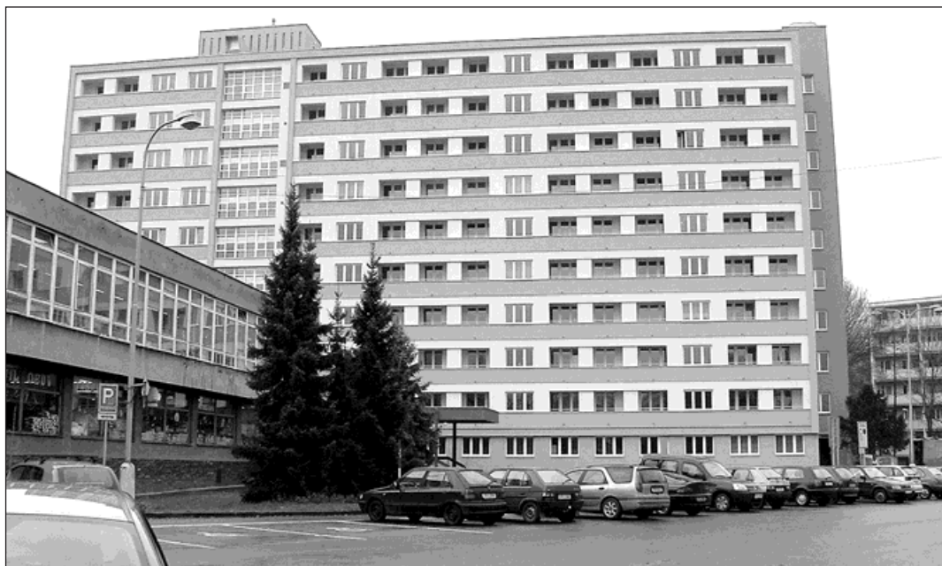
Už ne »hotelák«, nebo dokonce »opičák«, jak se taky přezdívalo bývalému hotelovému domu. Teď už bude zrekonstruovaný zářivě žluto-oranžový objekt jednou provždy Slunečnice. Foto: Mirka Hrbáčová
