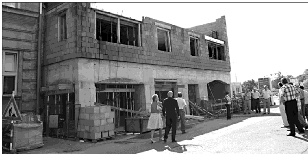
Zastávka u rozestavěného bytového domu na náměstí Svobody ve Starém Bohumíně. Foto: Lucie Balcarová
