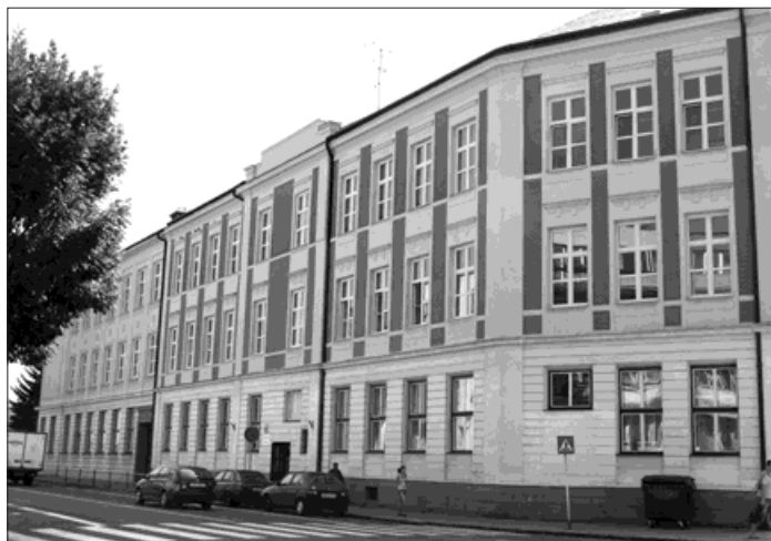
Dvě horní patra školy na tř. Dr. E. Beneše dostala o prázdninách nová plastová okna.
