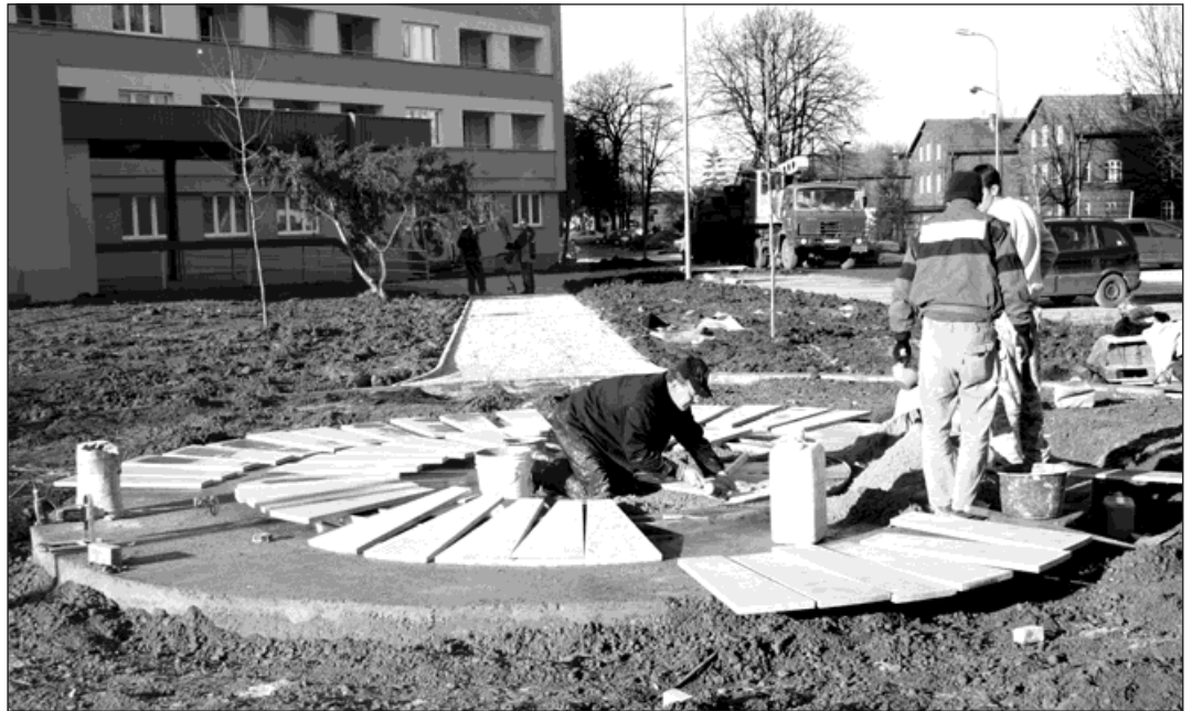
Místo, kde na jaře vytrysknou čtyři prameny vodotrysku, nepůsobí dnes ještě esteticky. Získává teprve svou budoucí podobu. Foto: František Krejzek
