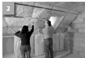
Aplikace parozábrany pod již vloženou tepelnou izolaci
