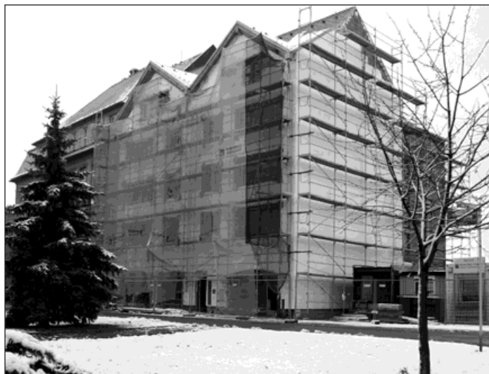
V současnosti se zatepluje obvodové zdivo domu. Foto: Lucie Balcarová
