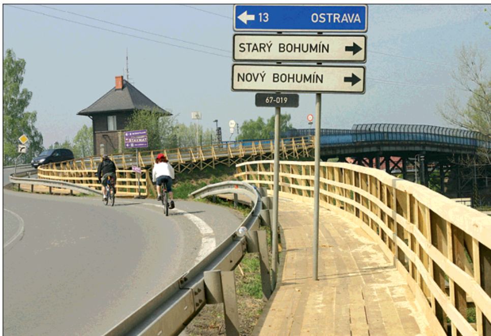
Lávka pro pěší a cyklisty přechází bourání mostu přes trať a po dobu dvou let bude nahrazovat přemostění. Foto: František Krejzek
