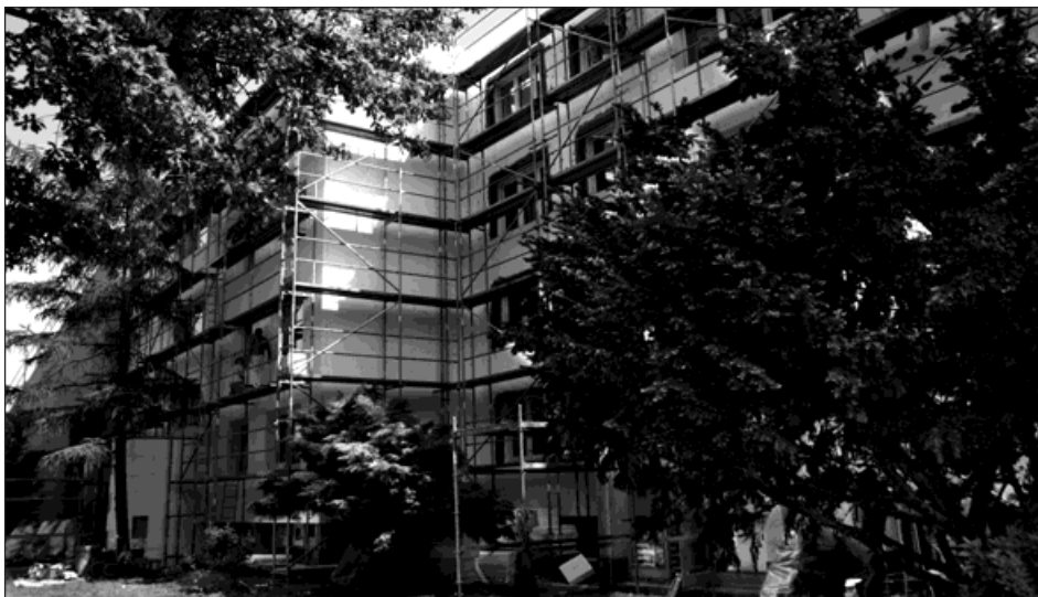
Zateplení městského domu na Čáslavské ulici.
