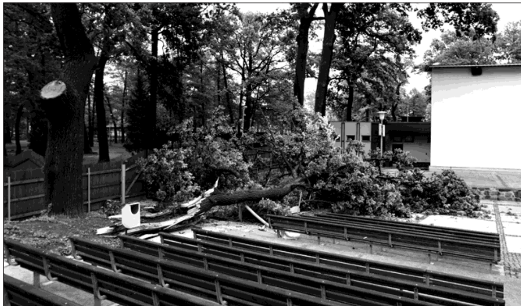
Mohutná větev, která byla, jak se ukázalo, uvnitř prohnulá, zlomila při pádu sloup veřejného osvětlení na ploše letního kina. Foto: Karel Balcar
