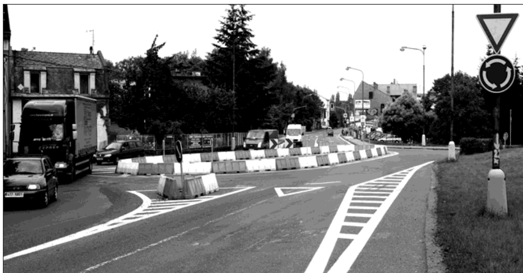
Nově upravená křižovatka ve Skřečoni s kruhovým objezdem zjednoduší a zpřehlední dopravu ve směru Bohumín - Karviná i Rychvald - Nová Ves. Foto: František Krejzek
