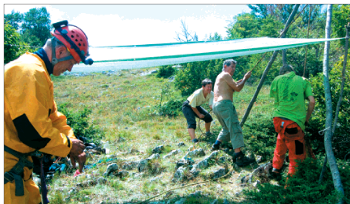
Nad ústím Bohumínské propasti vyrostla koza s kladkou na vytahování vaků s kameny. Foto: Josef Wagner
