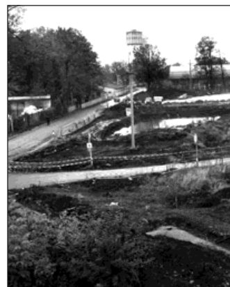
Stavba komunikace I/67 probíhá v těsné blízkosti aquacentra.
