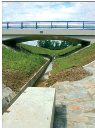
2003: Začíná první etapa stavby protipovodňových hrází ve Starém Bohumíně a Sunychlu.
