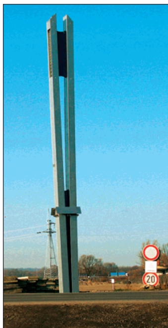
Pylon na Ostravské ulici, na němž bude zavěšena pěší lávka přes dálnici směrem do Starého Bohumína.
