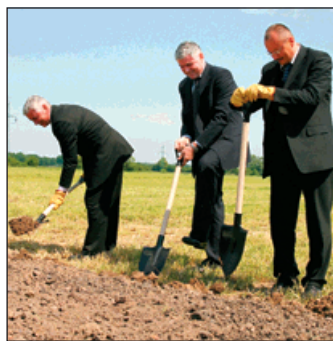
Po slavnostním výkopu teplovodu z Dětmárovice se v Bohumíně začaly pokládat horkovodní rozvody.
