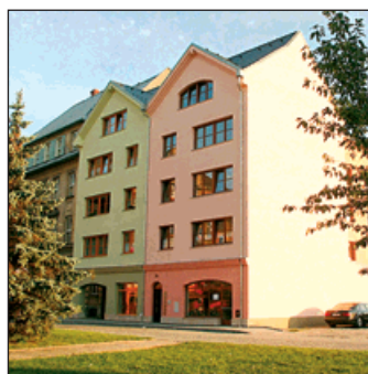
Na náměstí Svobody vyrostl první z domů, které by měly zaplnit prohluku mezi Domovem Jistoty a ulicí Čs. armády.
