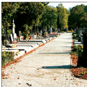
Nové chodníky na hřbitově ve Starém Bohumíně.
