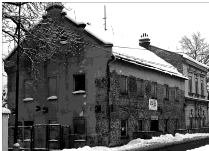
Na budově Myslivny na Slezské ulici visí panel s termíny rekonstrukce, který také ukazuje, jak bude objekt vypadat. Foto: František Krejzek
