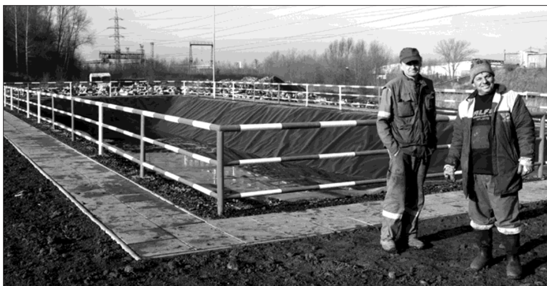
Jímka pro zachycování odpadních vod pro 3. etapu skládky komunálních odpadů v Bohumíně. Foto: Lucie Balcarová
