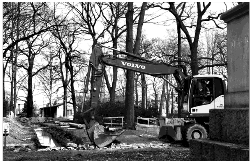
Chodníky v parku, pod nimiž se pokládá horkovodní potrubí, budou mít po dokončení nové povrchy.
