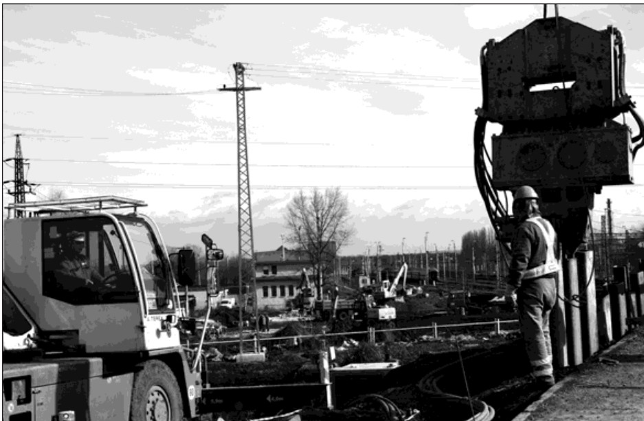
Stavba stěny z larsenů pro bezpečnost chodců na pěší lávce.
