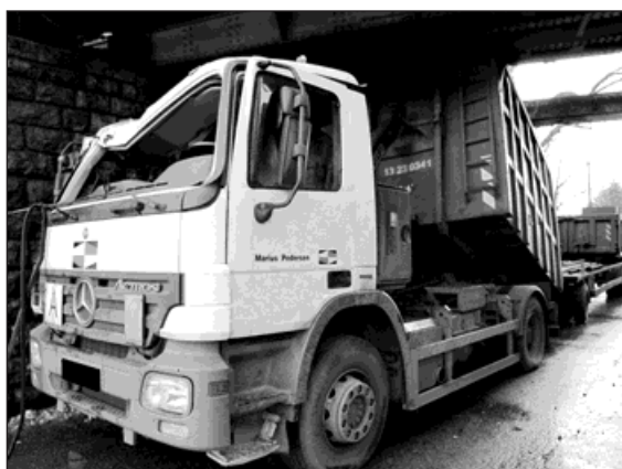
Náraz nákladního automobilu nadzvedl kolejový svršek a celý ho prohnul. Foto: Policie ČR
