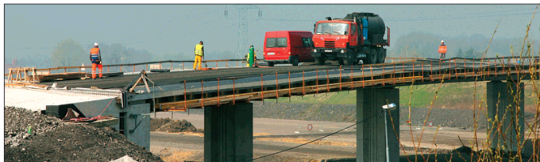
První dokončenou stavbou přes dálnici bude nadjezd na Slezské ulici. Otevře se 1. července. Foto: F. Krejzsek
