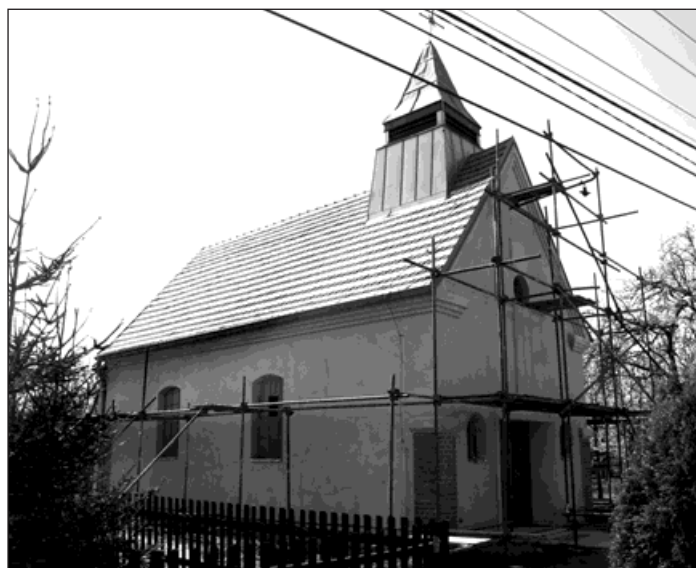
Kaple v Kopytově prochází druhou etapou oprav, letos bude rekonstrukce dokončena. Foto: Jiří Rozsypal
