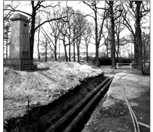
Potrubi přiváděče tepla z dětmarovické elektrárny potulo také park. Foto: František Krejzek
