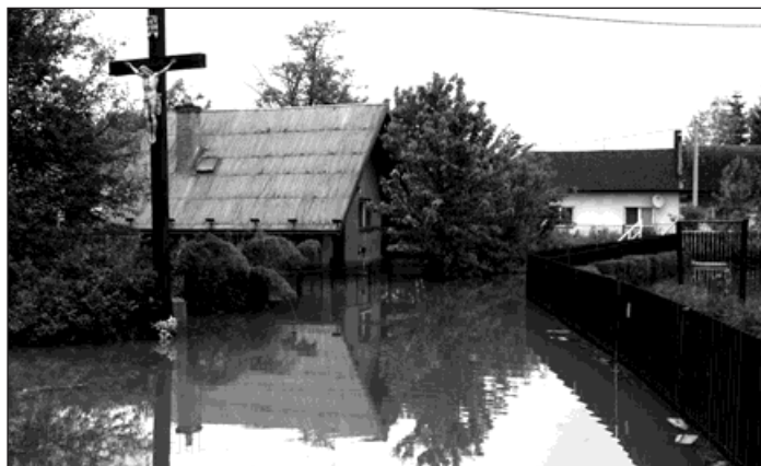
Domy v Šunychlu a Kopytově na tom byly při povodni nejhůř.
