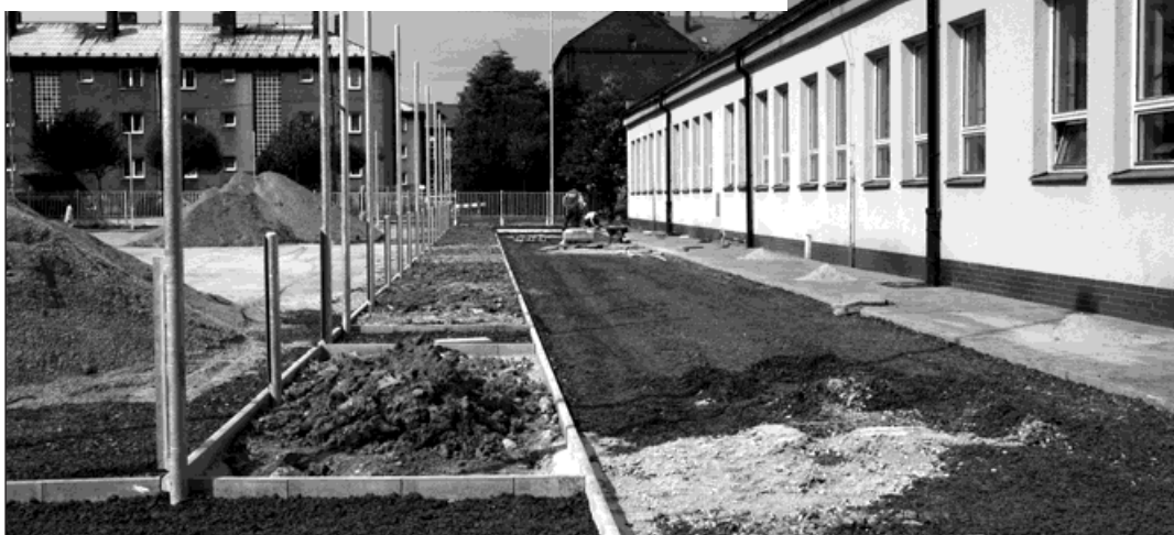
Nahoře vizualizace školního dvora Masarykovy základní školy, dole výstavba rozběhové a sprinterské dráhy.
