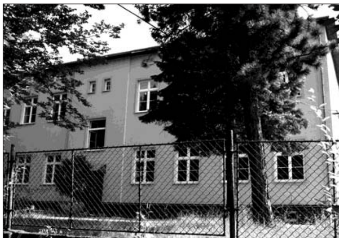
Budova Základní školy v Záblatí má nová okna.
