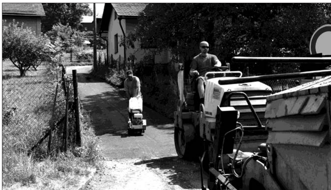
V části ulice Svážné v Záblatí byl položen nový asfaltový koberec.
