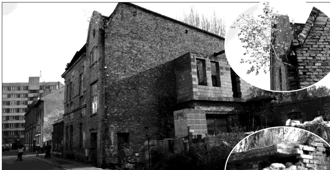
Neudržovaná soukromá nemovitost v Žižkové ulici hyzdí okolí v samém centru města a začíná být i nebezpečná. Foto: Pavel Čempěl
