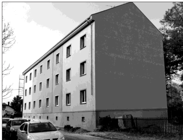
Přestavba domu přijde město na téměř čtrnáct milionů. Náklady pokryje úvěr a částečně vybrané nájemné. Foto: Pavel Cempěl
