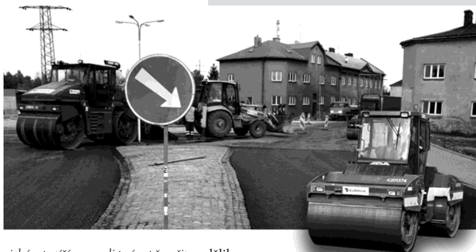
Položením finální vrstvy asfaltu u budoucího skřečoňského mostu skončil nepříjemný jednosměrný provoz řízený semaforem. Foto: Pavel Čempěl
