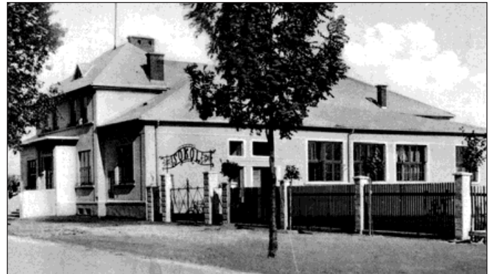
Pohled na záblatskou sokolovnu je z roku 1933. Ale Sokol je zde daleko starší - byl v Záblatí založen v roce 1911.
