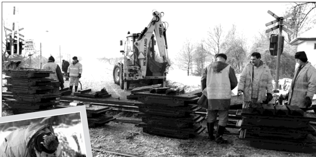
Za mrazivého počasí museli pracovníci správy trati demontovat celou přejezdovou konstrukci a prasklou kolejnici vyměnit. Přejezd u bývalé Rybeny byl po dobu oprav pro motoristy uzavřen. Foto: Pavel Čempěl
