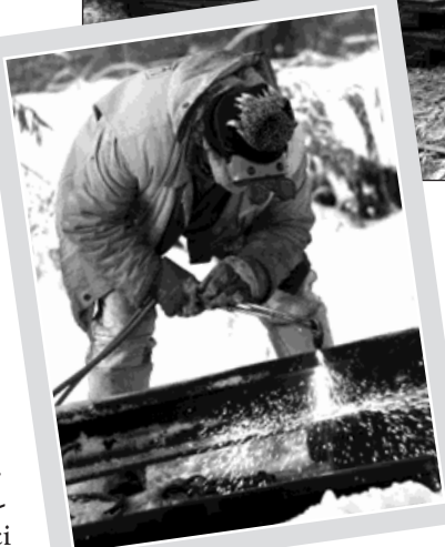
Za mrazivého počasí museli pracovníci správy trati demontovat celou přejezdovou konstrukci a prasklou kolejnici vyměnit. Přejezd u bývalé Rybeny byl po dobu oprav pro motoristy uzavřen. Foto: Pavel Čempěl
