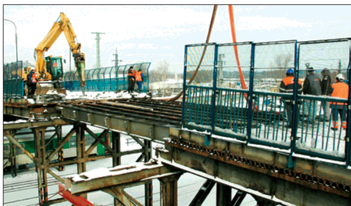
V lednu začalo odstraňování starého skřečošského mostu.
