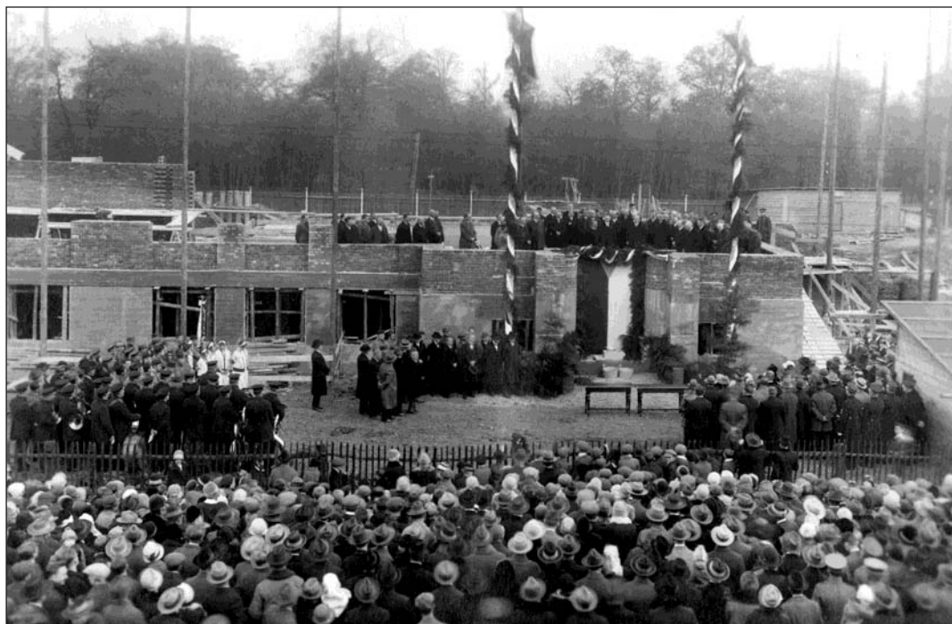
Stavba gymnaziální budovy v tehdy neupravené části městského sadu. Položení základního kamene proběhlo u příležitosti devátého výročí vzniku samostatného státu 28. října 1927. Foto: Archiv gymnázia
