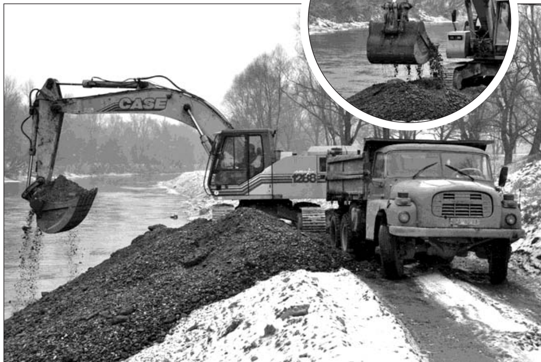
Kvůli urychlení prací vyhrnula na podzim těžká technika štěrky nejprve do stran. Odtud je nyní odváží nákladní auta. Foto: Pavel Čempěl
