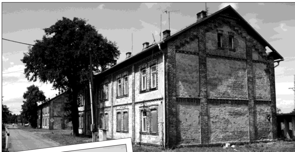
S bouráním čtyř domů v ulici Petra Cingra se počítá v říjnu a listopadu. Místní nenechavci už začali s »demolicí« po svém. Z vybydlených domů ve velkém odnášejí dřevo a střešní krytinu.
