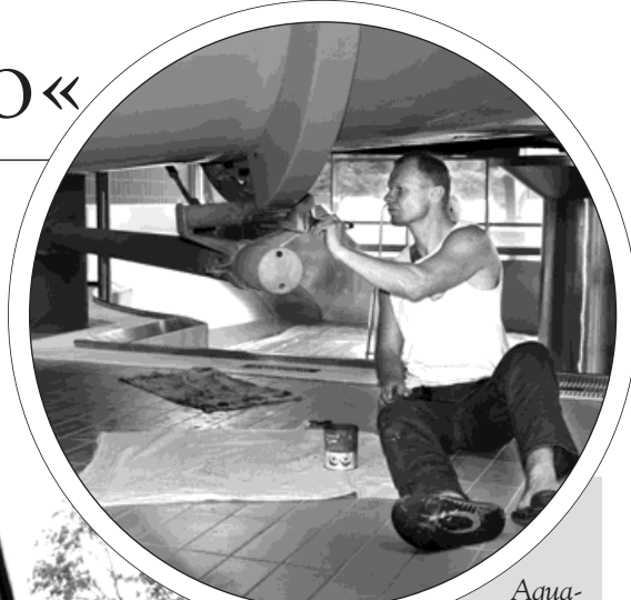
Aquacentrum zažilo velké gruntování. Spáry tobogánu bylo třeba vymělit a jeho kovová konstrukce dostala nový nátěr. Foto: Pavel Čempěl
