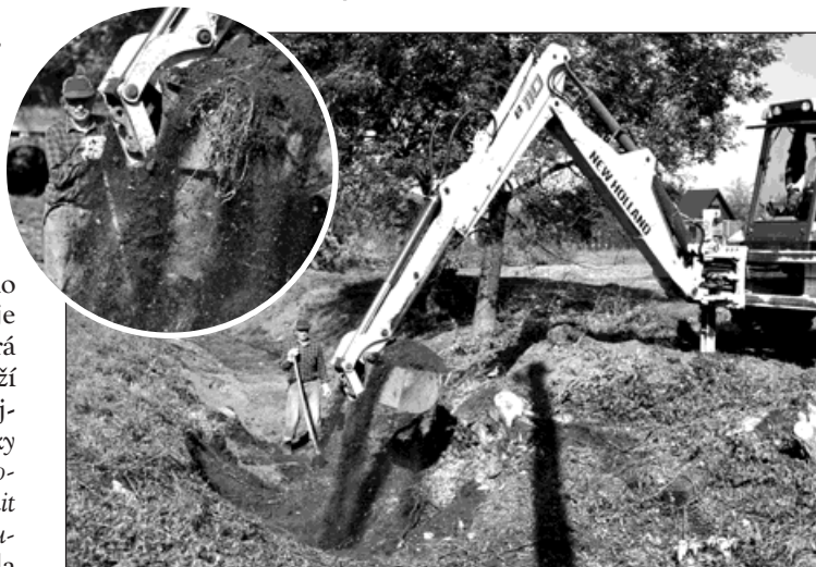
Zeminou i odpadem zanesený suchý příkop v Pudlově čistila těžká technika. Foto: Pavel Čempěl
