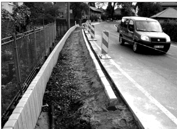
▲ Sto čtyřicet metrů dlouhý chodník ohraničuje zídka z betonových palisád. Jiné řešení nepřicházelo v úvahu. ▼ Jasan nešel k zemi kvůli chodníku. Až v průběhu stavby ho pokáceli silničáři. Foto: Pavel Čempěl
