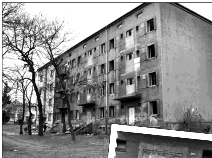
Zdevastovaný dům Na Loukách. V půlce domu, která sloužila jako holobyty, už jsou zazděné vchody. Totéž čeká i druhou část.
