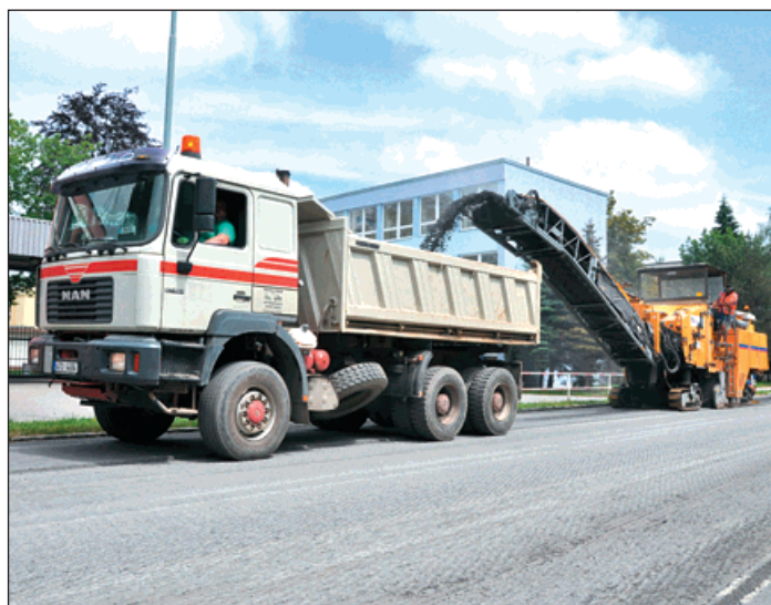
Frézování 1,5 kilometru dlouhého úseku probíhalo za provozu. Kvůli asfaltování je ale nutné silnice uzavřít. Foto: Pavel Čempěl
